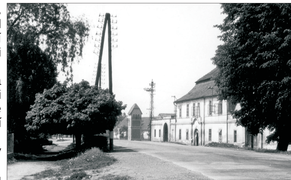
Pohled na Starou poštu od Českobrodské ulice v roce 1959
