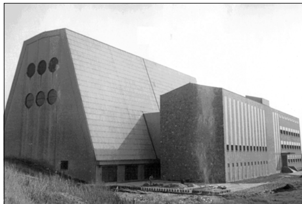
Dokončení hrubé stavby v září 1952.
