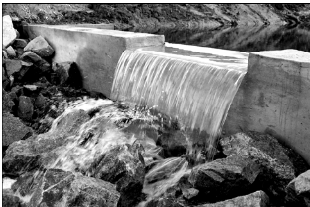
Jalovka má nový splávek i stavidlo, pokračují úpravy břehů.
