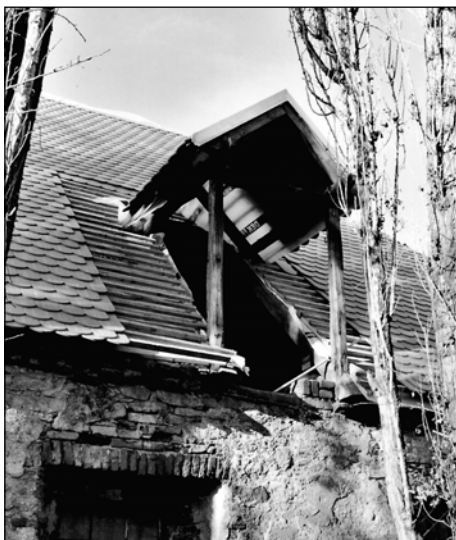
Další část střechy Staré pošty je obnovena.
