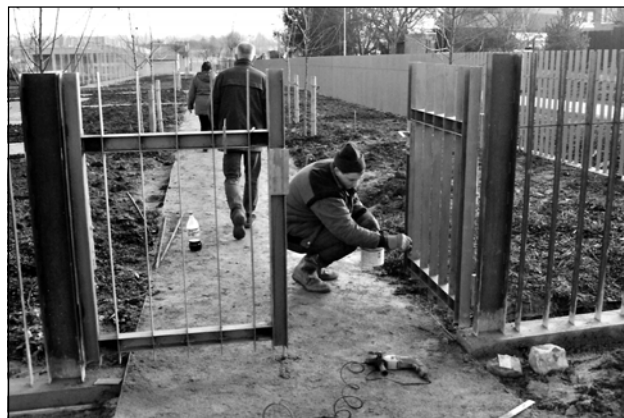
Probíhá kolaudace Běchovického parku a dokončovací práce.
