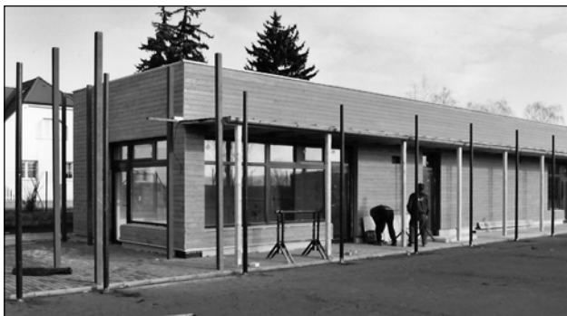
Areál Na Korunce je před dokončením.
