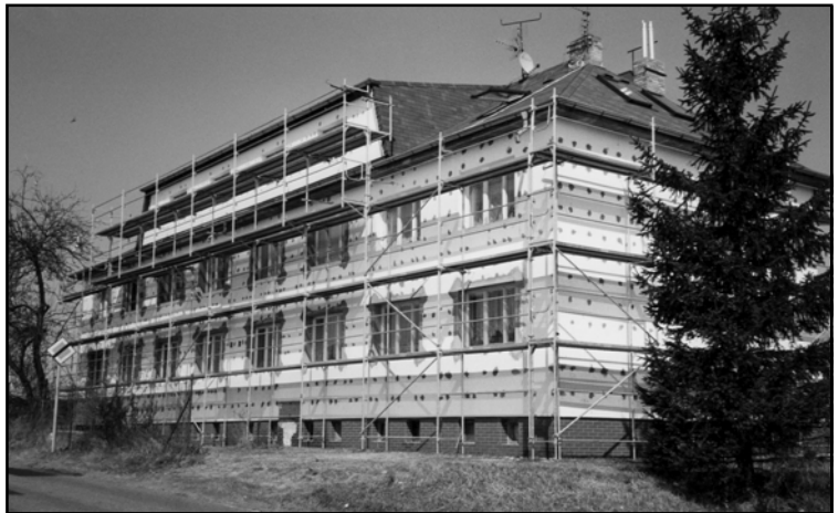
V jarních měsících bylo dokončeno zateplení třetího bytového domu v ulici Do Panenek.
