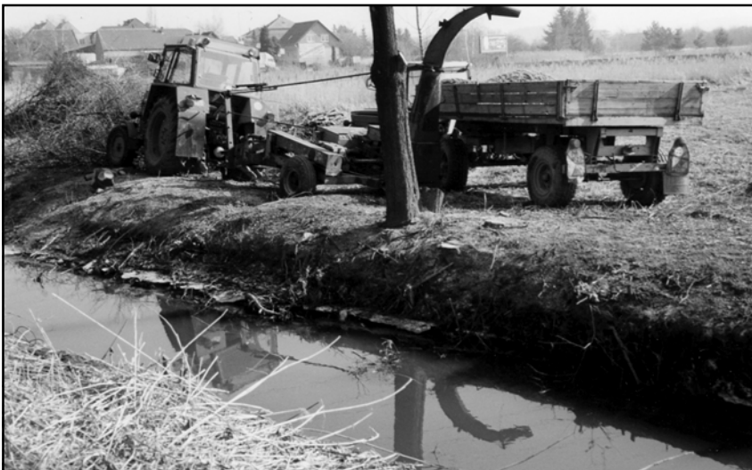
Firma ZISTA provedla vyčištění Běchovického potoka, břehů a jeho nejbližšího okolí od náletových dřevin, rákosí a nepořádku.
