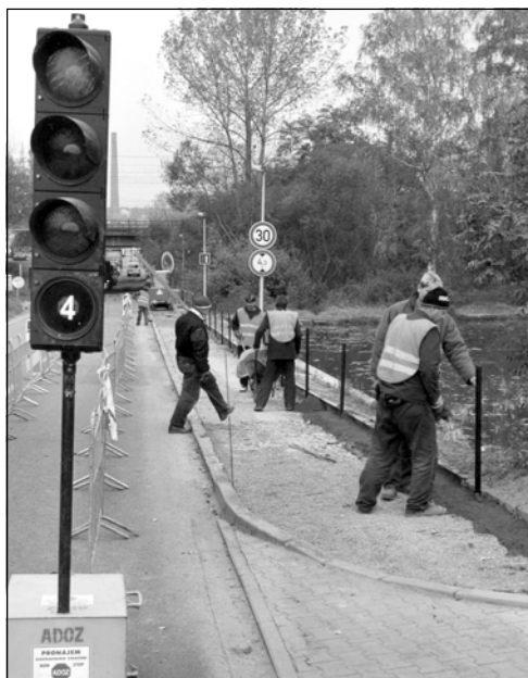
Krátkodobá dopravní omezení kolem rybníčku jsou v důsledku výstavby poslední části chodníku mezi středem obce a areálem výzkumných ústavů.
