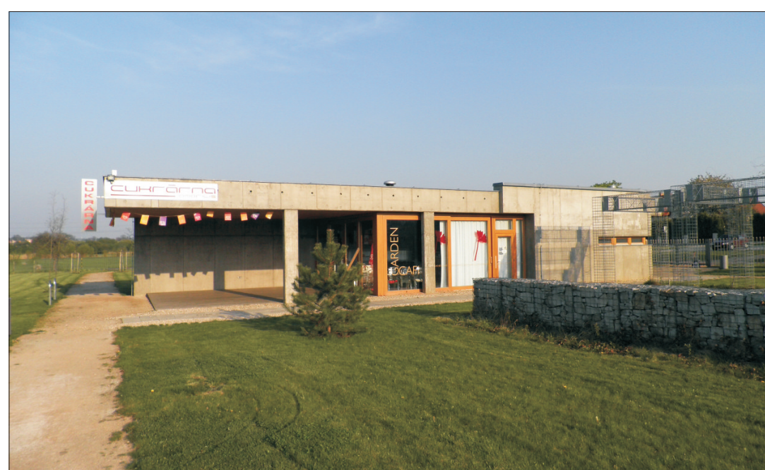
Budova cukrárny v současné době (duben 2010)
