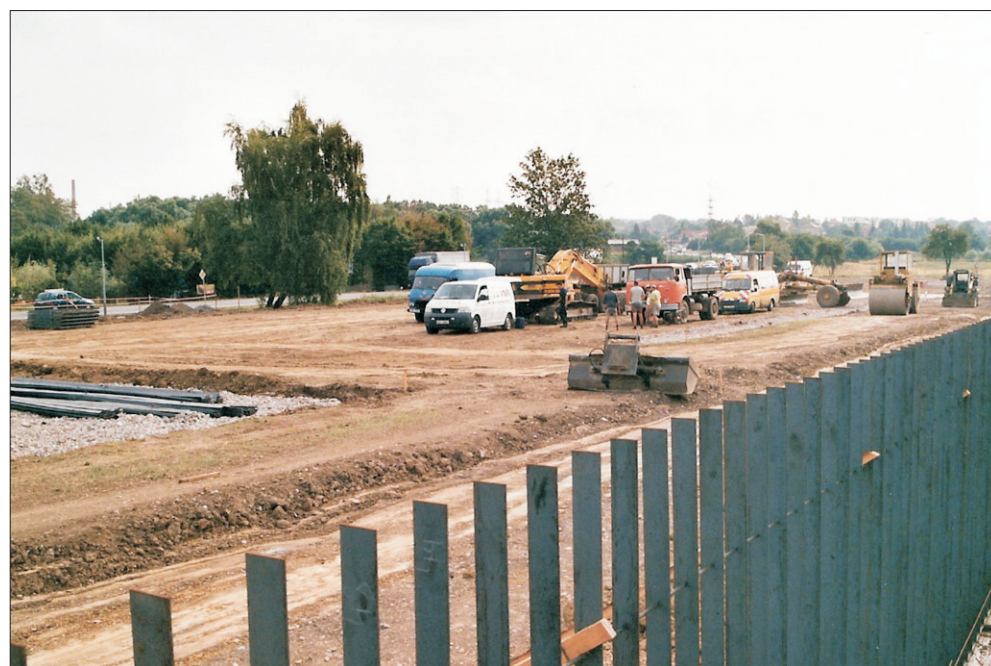
Probíhající výstavba parku (1. října 2006)
