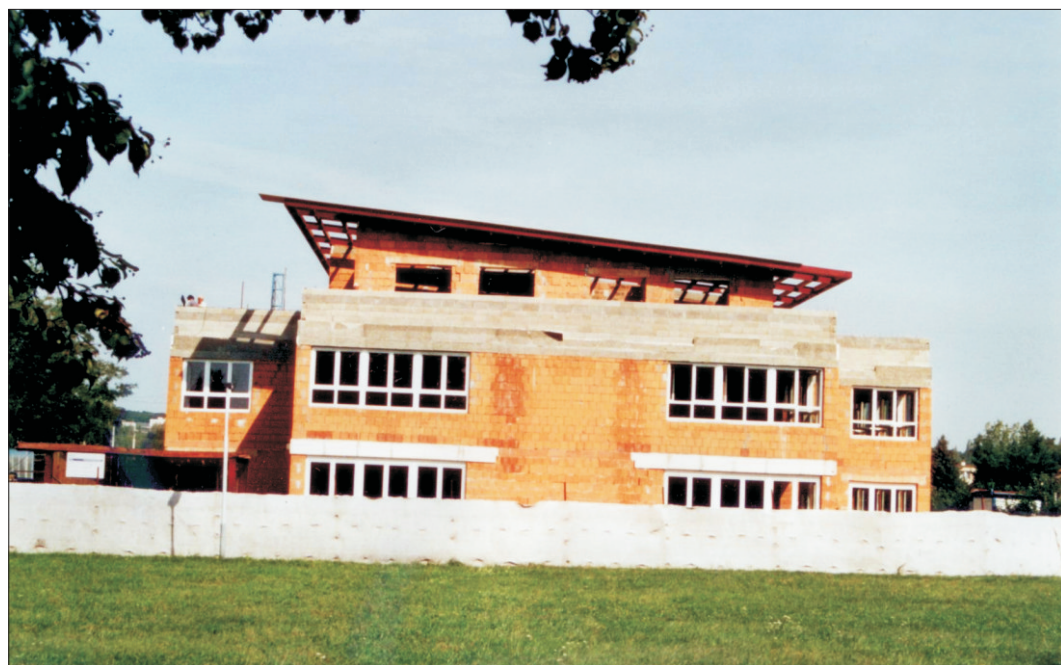
Stavba mateřské školy - srpen 2008
